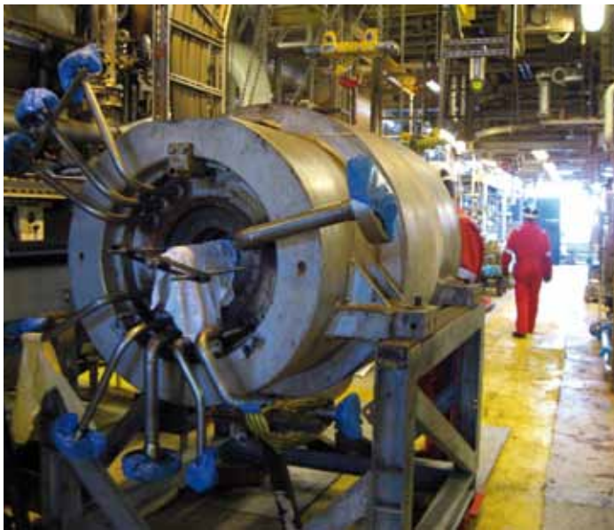
TIL REPARASJON: Dette er kompressoren som ble overhalt.
