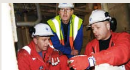
VENTILER: John M. Karlsen, John Moholt, vedlikeholdsingeniør ved Follum, og Magnus Ralle Gran vedlikeholder ventiler.
