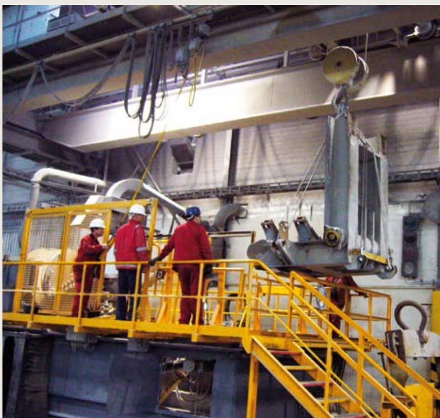
RASKT: Kippen ble rengjort, og festene til hydraulikksylindrene og lagrene ble fullstendig fornyet. Digel-rengjøringsmaskinen kunne monteres følgende dag og settes i drift til avtalt tid.
