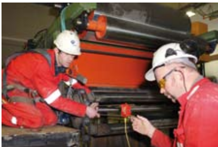
OPPRETTING: Ronny Amundsen, HPP, og Pål Kokkersvold, HPP, retter opp valser.
