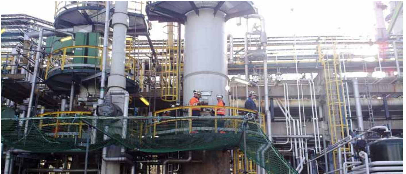
REVISJONSSTANS: BIS PP Interpipe i Stenungsund skal levere både planlegging og utførelse under revisjonsstansene ved Perstorp Oxo ABs anlegg i Stenungsund og Nol. Dette bildet er BIS PP-ansatte i arbeid under den forrige revisjonsstansen ved Perstorp Oxo.
