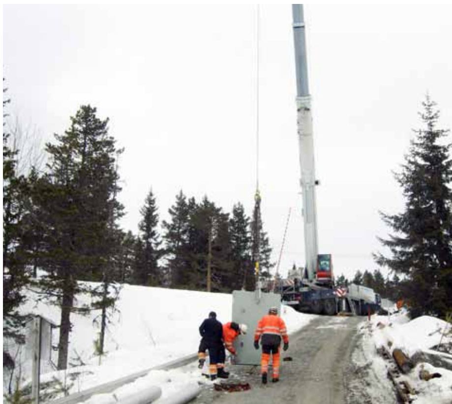
KRAFTVERK: Inntaksluka er prefabrikkert ved plateverkstedet i Porsgrunn. Den står nederst i en 25 meter dyp sjakt og ble firt ned med kran.
