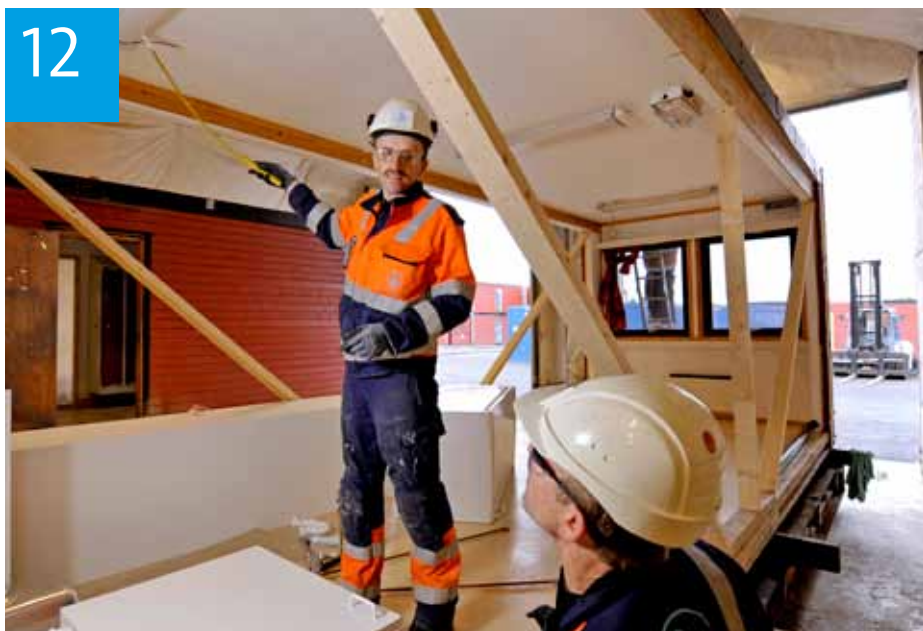
RESULTATER: Tømmerbas Ernst Harald Larsen forklarer driftsleder Eirik Fjeldkårstad viktigheten av å stripe lysarmaturer under transport slik at de ikke faller ned.
