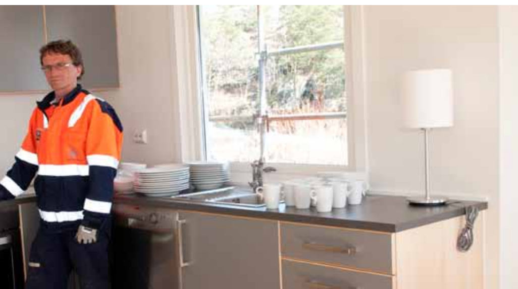
NY INNREDNING: De 12 nyrestaurerte hyttene har fått ny kjøkkeninnredning forteller tømrer Stig Stamland fra BIS PP Bygg Grenland.
